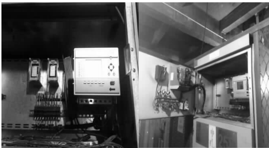
图9 新增设四方保护装置的安装及两套保护装置的二次回路改进、配线
