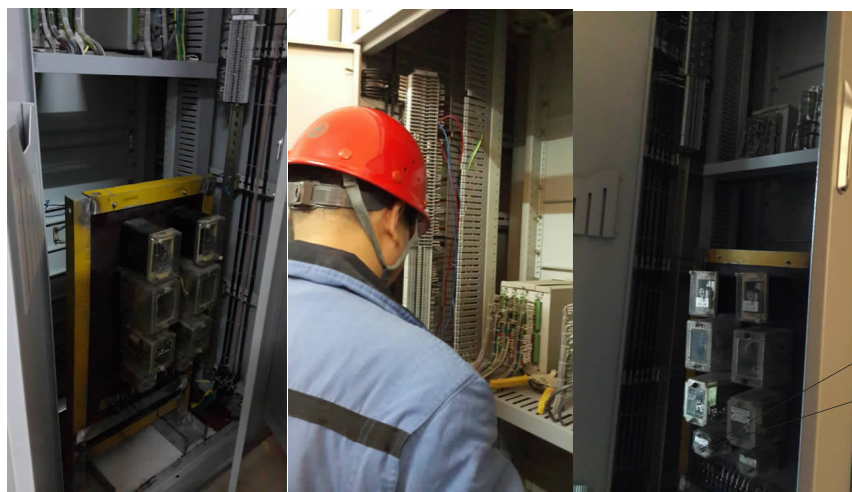
图 4 完成零序过压保护动作回路施工情况
