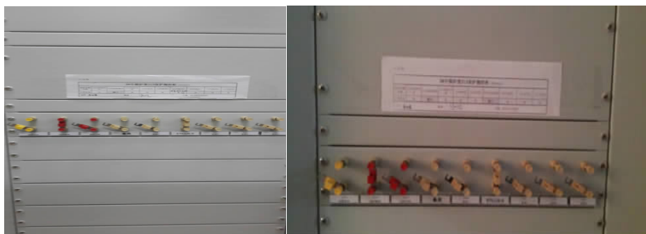
图 5 更换 35kV 线路保护屏内压板投切状态
